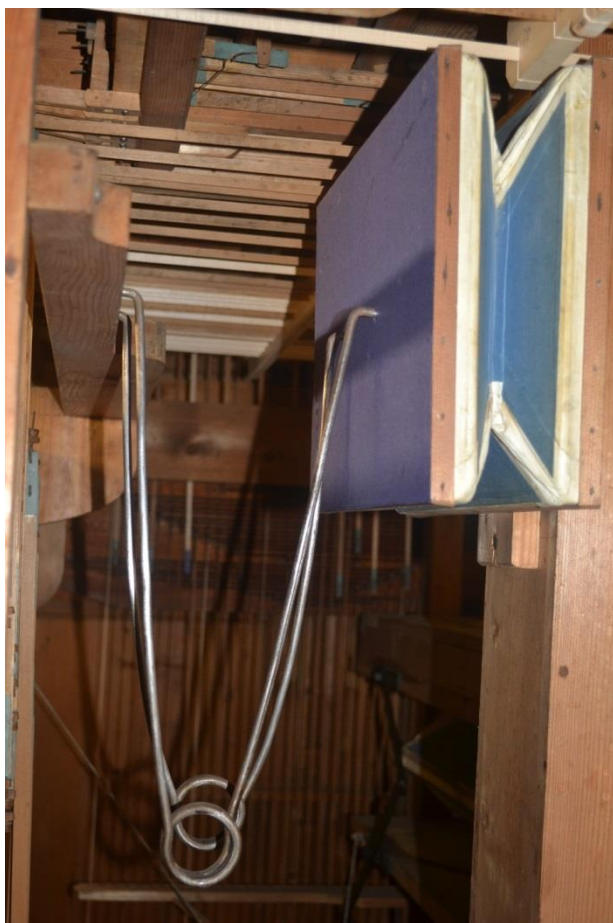
Slika 21: Izravnalni meh (foto: Brane Košir)
