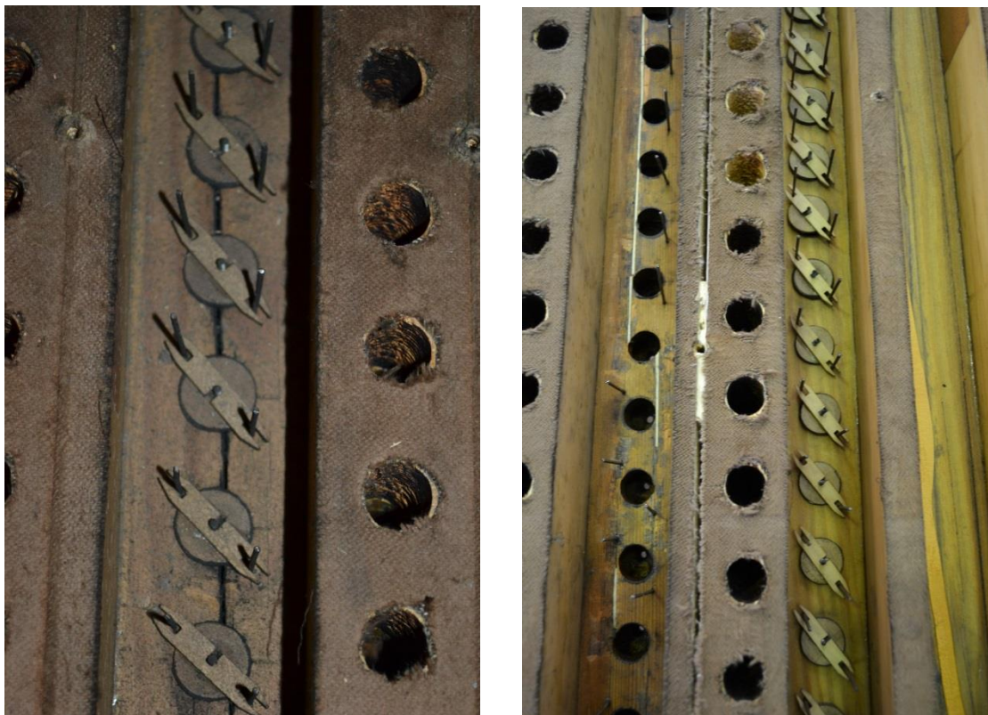
Sliki 29 in 30: Stanje sapnic pred in po restavriranju (foto: Brane Košir)
