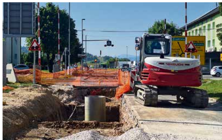
Gradbišče Ivančna Gorica
